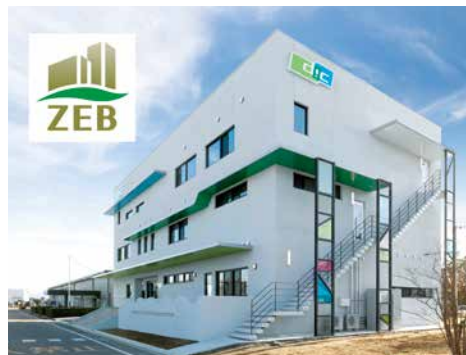
ZEB*4工法を取り入れたDIC九州ポリマ事務棟
