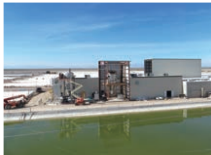
建設中の新プラント。手前は原料となるスピルリナの培養池（アメリカ・カリフォルニア州）
