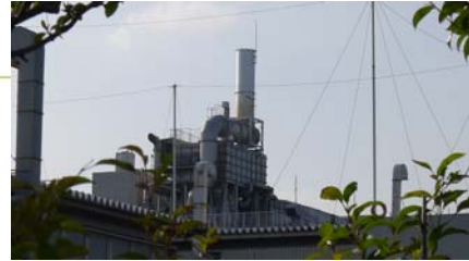
(写真2. VOC除害装置)
