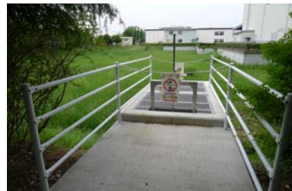
(写真6. 遊水池から公共水域への水門)
