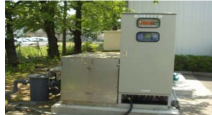
(写真4. 下水道への排水中和施設)
