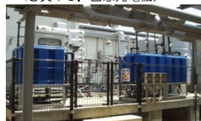
(写真12. 井水上水化装置)
