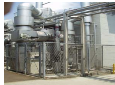
(写真10. 自家発電機)
