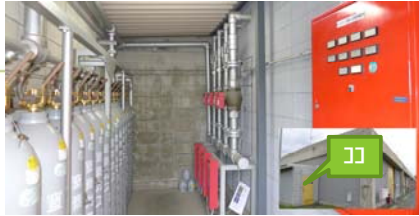
(写真1. 危険物倉庫のハロン消火施設)
