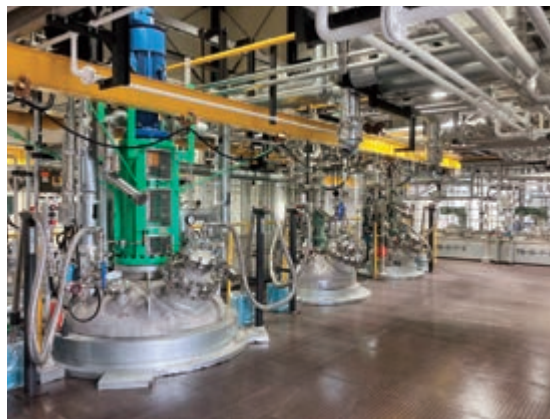
水性樹脂製造設備（日本）
