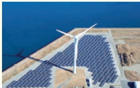
2018年に鹿島工場1,600kWメガソーラー（写真）が稼動し、2019年には新たに館林工場1,270kWメガソーラー等が稼動します。
