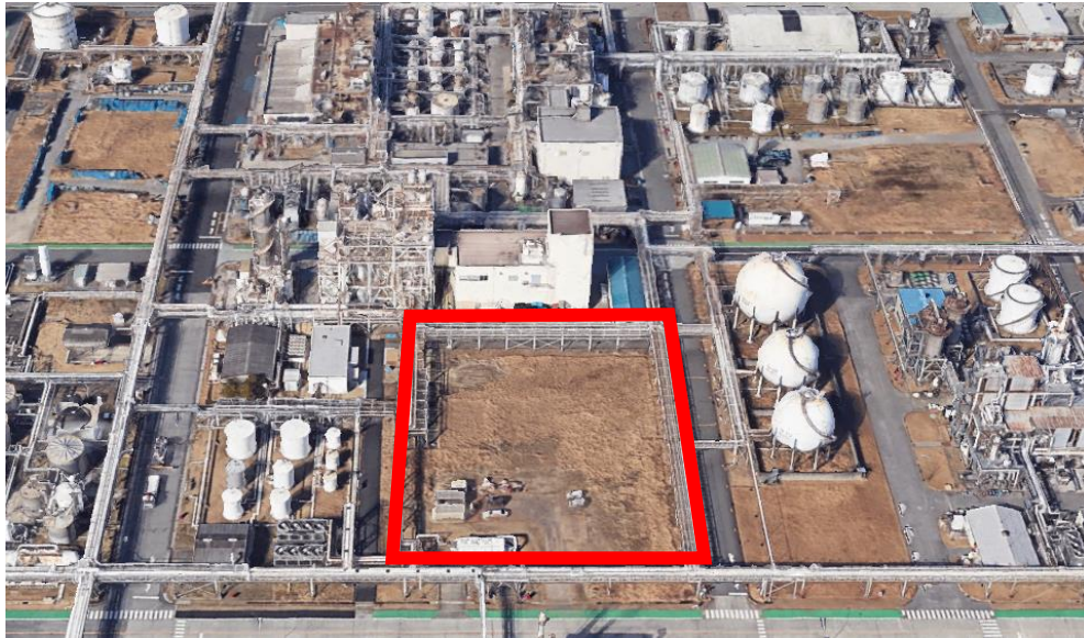
千葉工場 新プラント建設予定地
