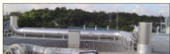
スプレー式脱臭ダクト
