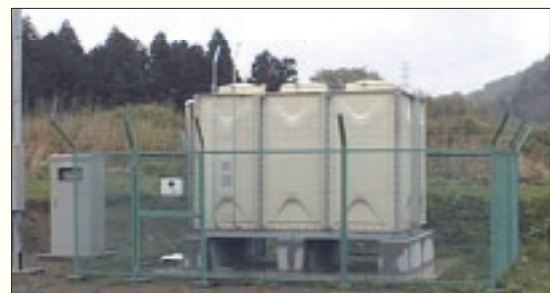
旧産業廃棄物埋め立て地に設置された地下汚染水の回収貯槽施設
