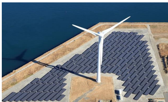
鹿島工場の太陽光発電設備（約 1.6MW）
