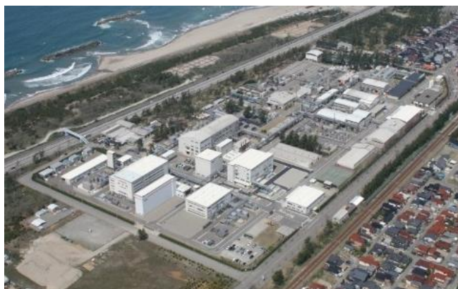
バイオマスボイラを導入する北陸工場
