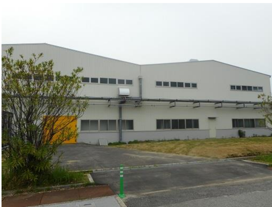
中空糸膜モジュールの新工場（千葉工場内）
