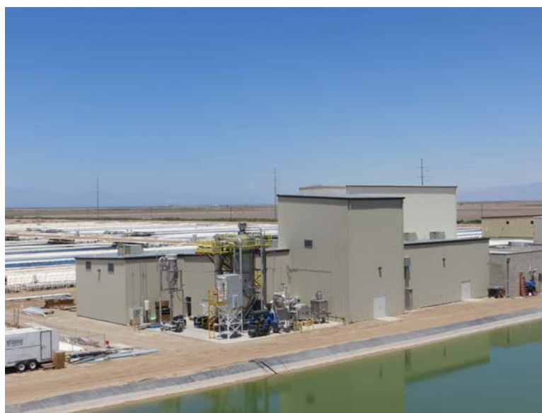
増設を行う天然系青色素抽出工場
