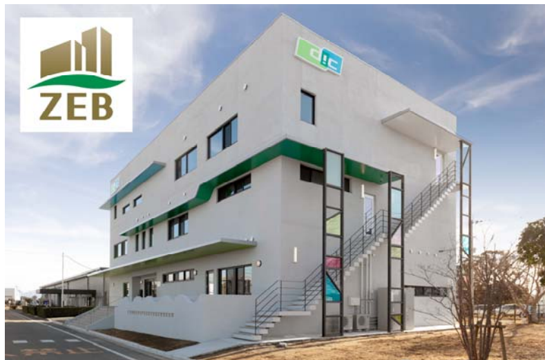
『ZEB』認証を取得した DIC 九州ポリマ（株）新事務棟
