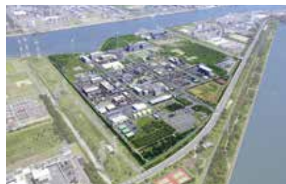
PPS樹脂の生産能力増強を進める鹿島工場 (茨城県)
