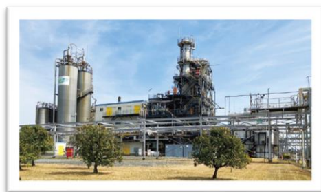
ポリスチレンの主力工場であるDIC四日市工場（三重県）に実証プラントを建設
