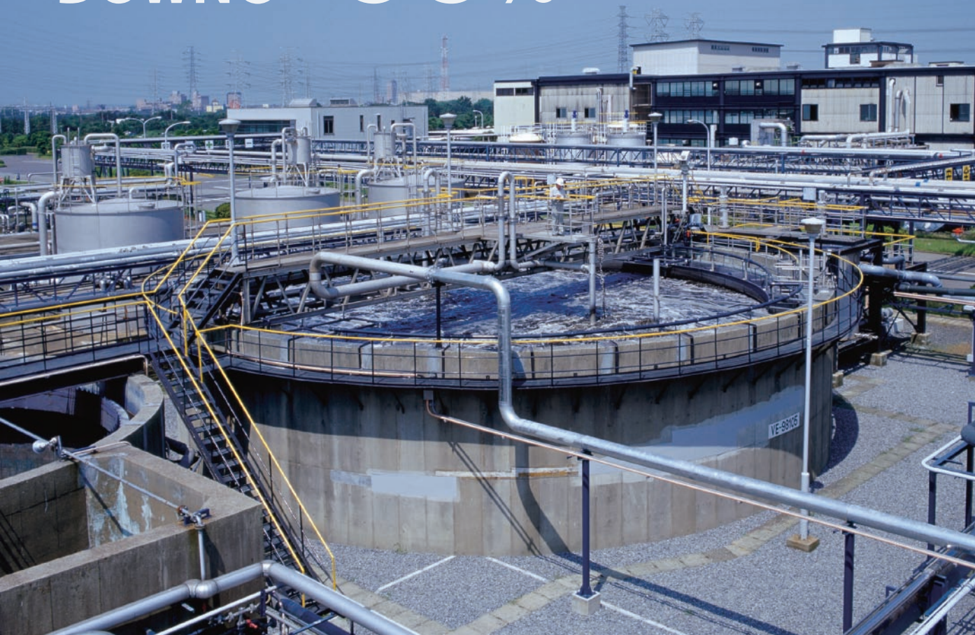
鹿島工場 汚泥処理施設
